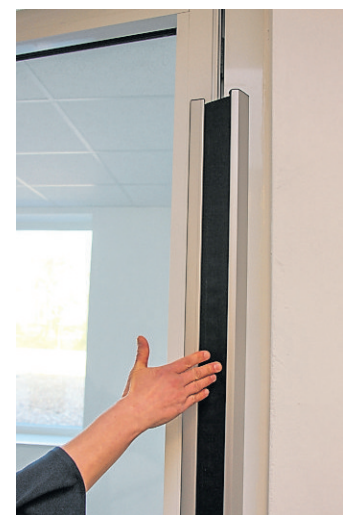
Ein Klemmschutz an den Türen soll verhindern, dass man sich die Finger klemmt.
